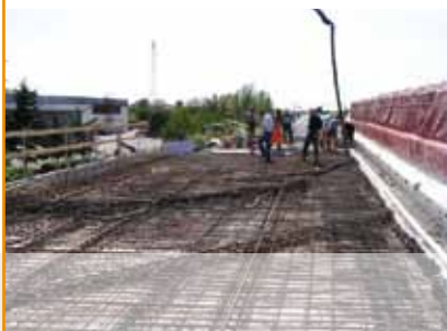
Autoroutes vénitiennes SR 53 avant et après l'entretien
